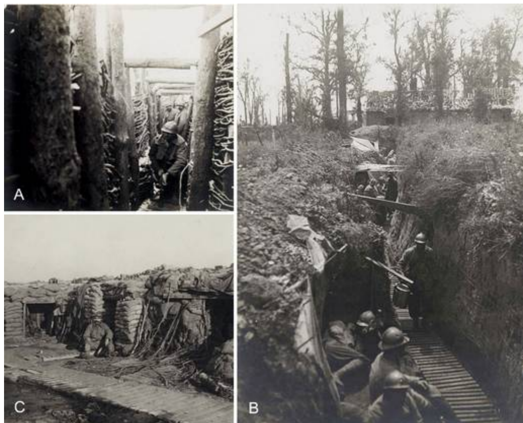
Fig. 4. Tranchées dans la Meuse (A), dans la Somme (B) et en Belgique, près de Nieuport (C). A : Xivray. 1917. Tranchée clayonnée (coll. La contemporaine VAL 230/150). Cliché Lt de Preissac. B : Foucaucourt (devant). 20 septembre 1916. Tranchée (coll. La contemporaine VAL 451/134). Cliché L. Schneider (coll. La contemporaine VAL 451/134). C : Lombartyde (devant). 28 janvier 1917. Tranchée française (coll. La contemporaine VAL 486/018). Les profils transversaux réglementaires des tranchées et boyaux retrouvés dans les manuels d'instruction militaire dépendent également de la nature des terrains. En terrain rocheux difficile à creuser, l'incision diminue. En terrain humide les talus intérieurs sont clayonnés, revêtus de bois et de fascines, lorsque la nappe est subaffleurante, le creusement est proscrit et la tranchée est surélevée
