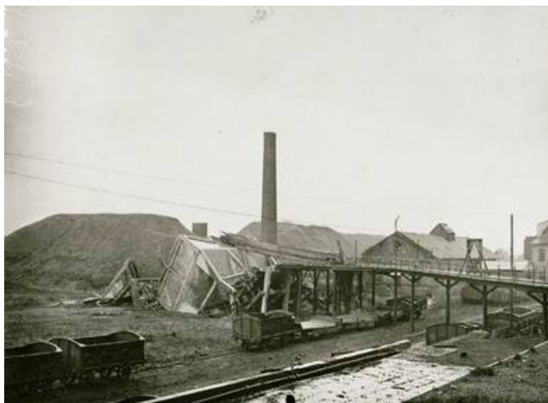
Fig. 7. Compagnie des mines d'Aniche. 10 décembre 1918. Près Dechy. Fosse Dechy détruite par les Allemands. Fours à coke ; réservoir à charbon en béton (coll. La contemporaine VAL 239/018).
