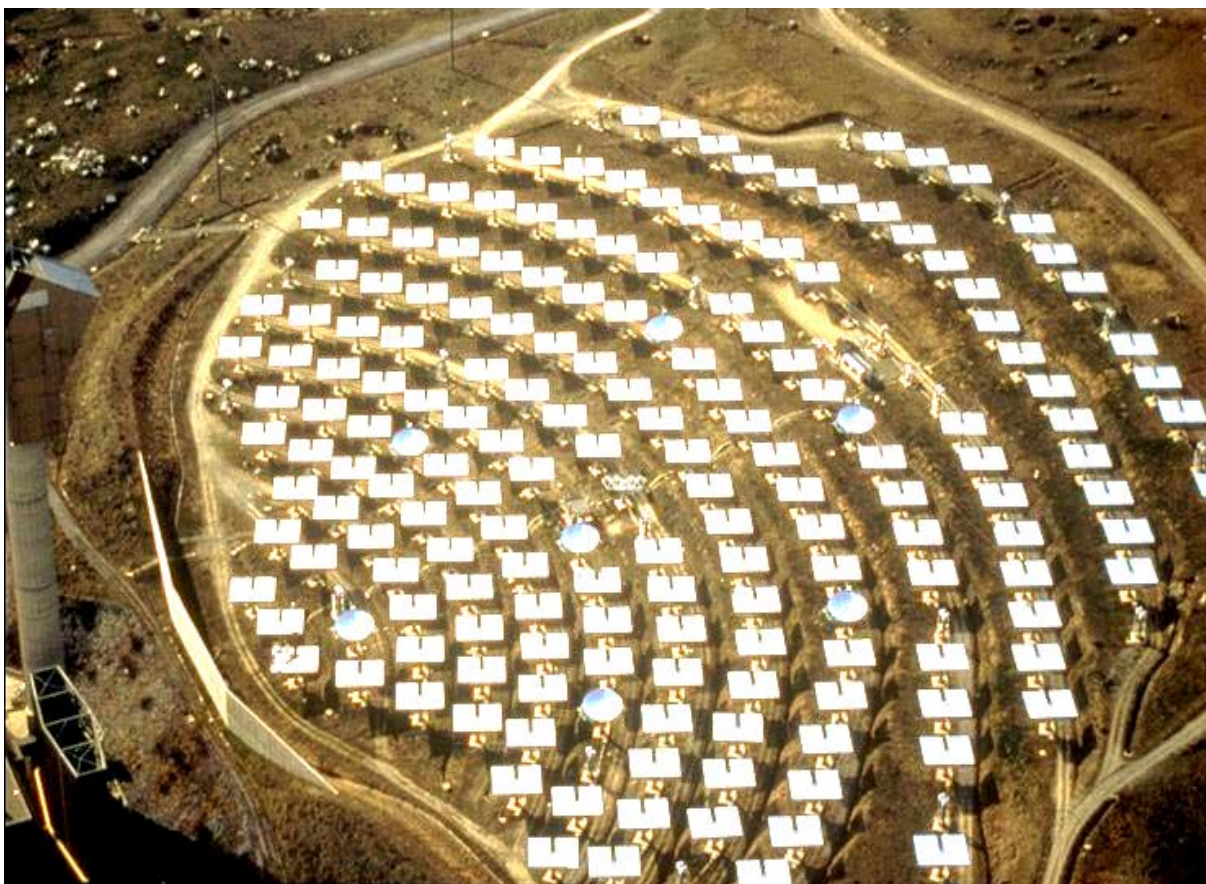
FIG. 4: Le champ des héliostats de Thémis vu d'avion. On devine à l'extrême gauche la tour portant le détecteur CELESTE
