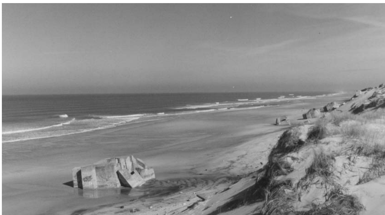
Figure 1. Un blockhaus, marqueur de l'érosion (Côte aquitaine, Hourtin).
