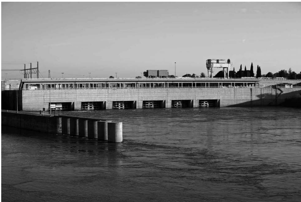
Vue de la centrale-écluse de Beaucaire (Gard) achevée en 1970.
