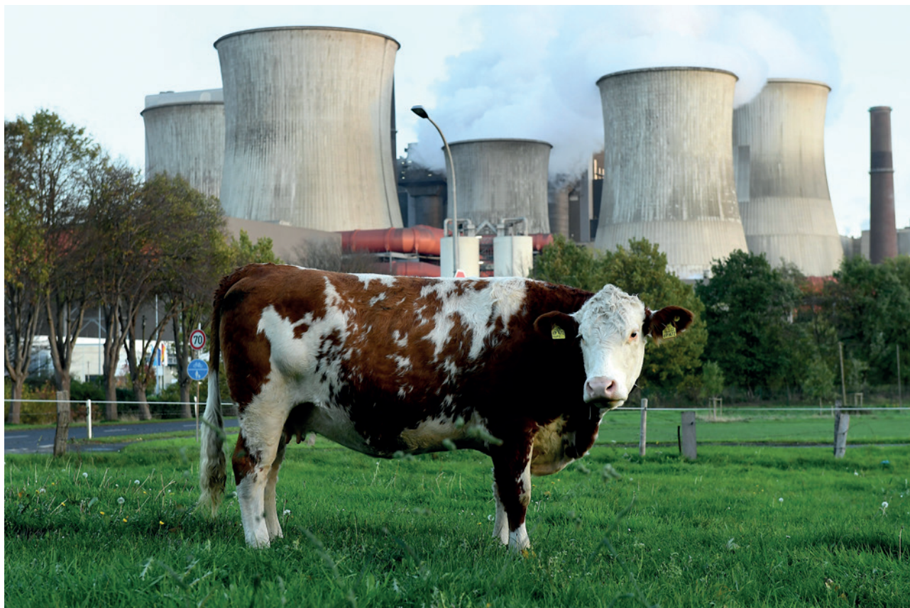
La centrale thermique au lignite de Bergheim (Allemagne).
