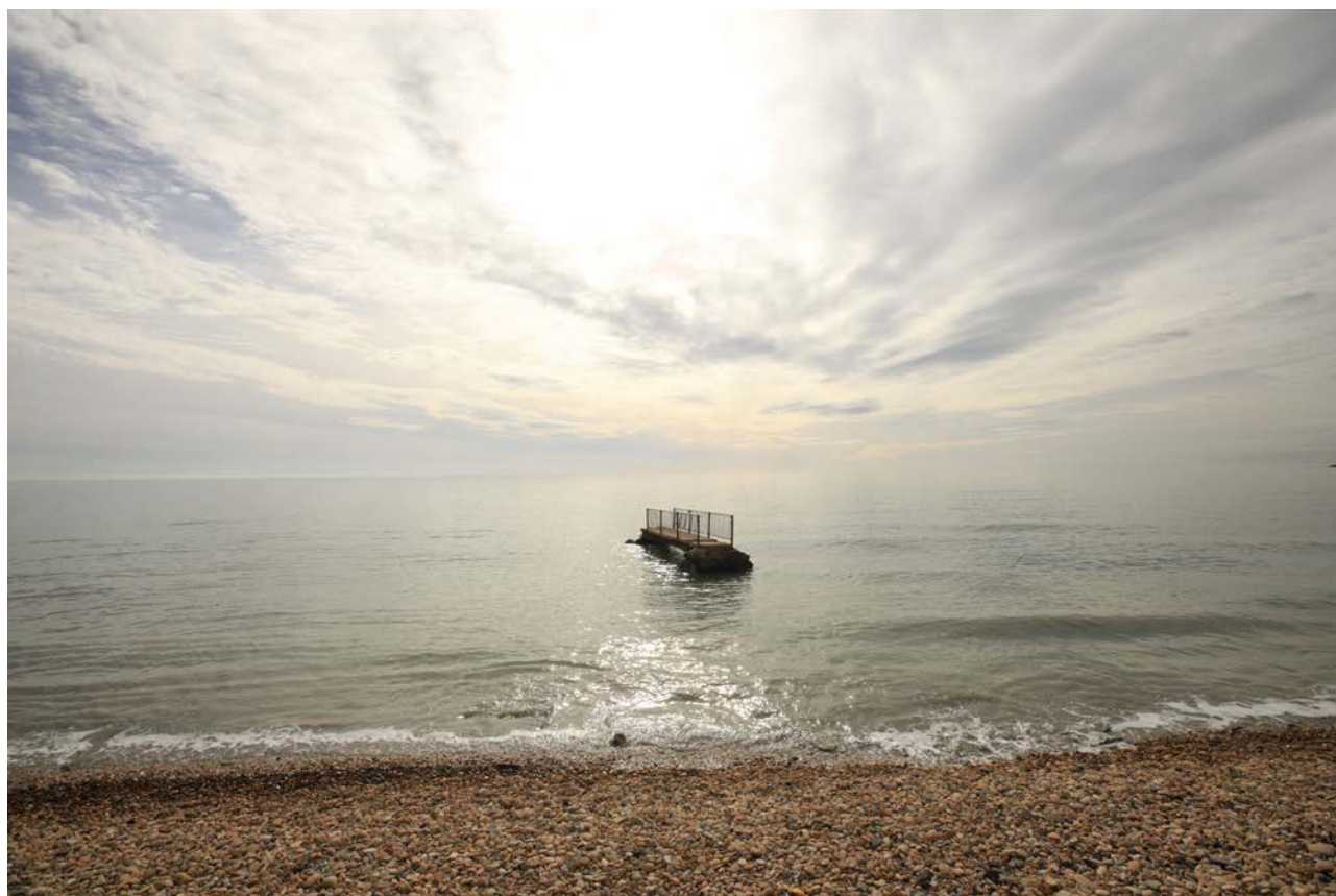
Figure 2. Une passerelle posée dans la mer, frêle témoin de l'importante érosion littorale – Saintes-Maries-de-la-Mer, 2019 (© J. Jalbert – Tour du Valat).
