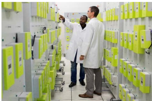
Le compteur communicant Linky constitue un maillon central de la numérisation des distributeurs d'électricité – Photo©Enedis.
