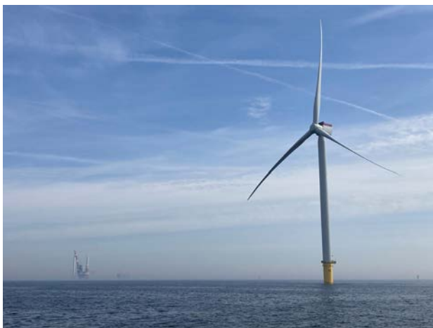
Installation d'une première éolienne grâce au navire Wind Osprey que l'on aperçoit en arrière-plan – Source : ©Vattenfall.
