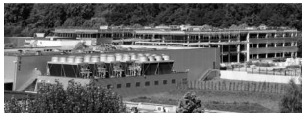
Photo 4 : TGCC Vue extérieur
