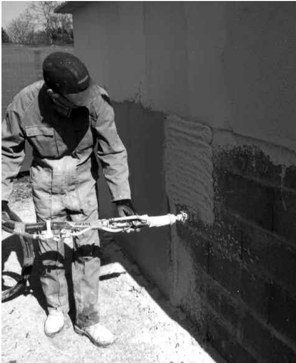
Application d'un mortier de façade réalisé à base d'aérogel de silice et de ciment. © Enersens
