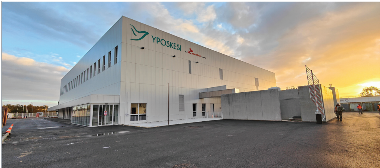
Figure 5: Nouveau bâtiment de bioproduction de vecteurs viraux d'Yposkesi.
