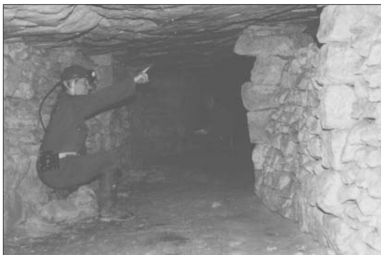
Inspection de galeries dans une carrière de calcaire grossier sous Châtillon.
