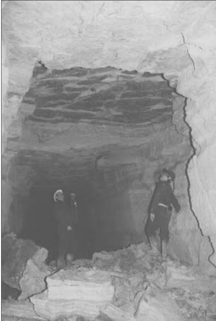
Ciel tombé, carrière de calcaire grossier par piliers tournés.
