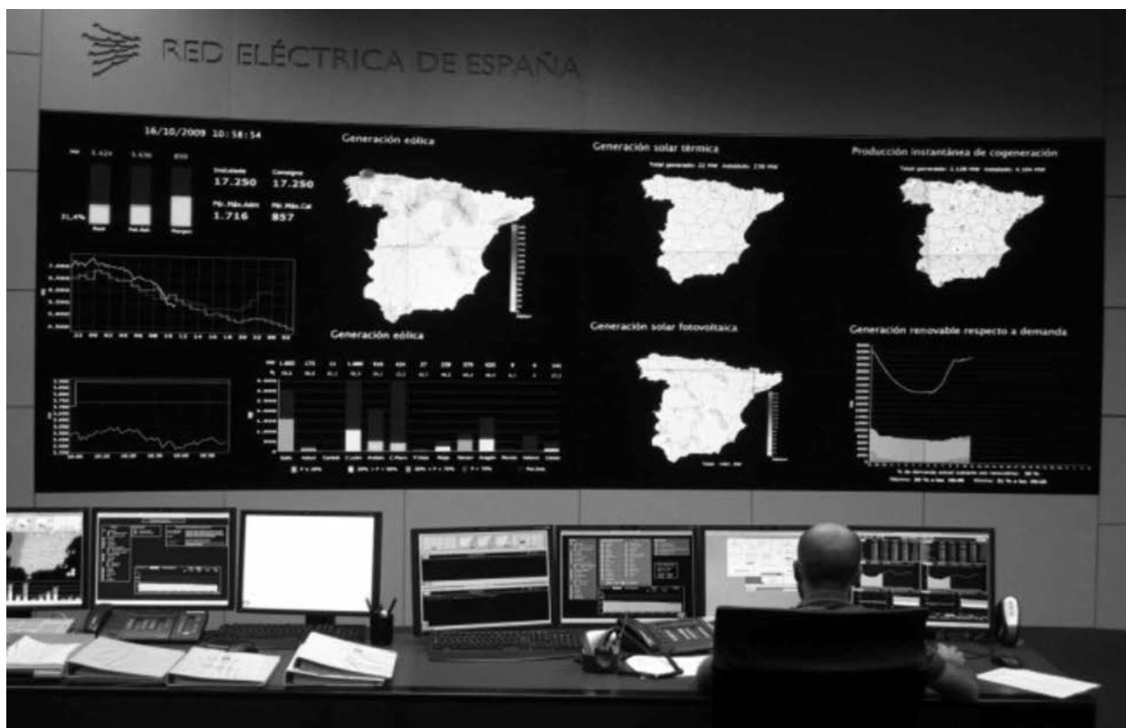
Figure 6 : Vue générale du CNCER.
