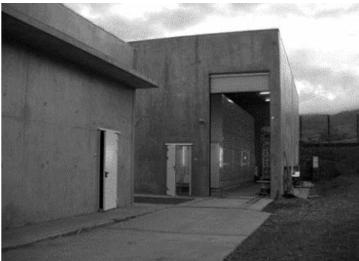
Photo 2 : Site de stockage d'électricité au moyen de batteries.
