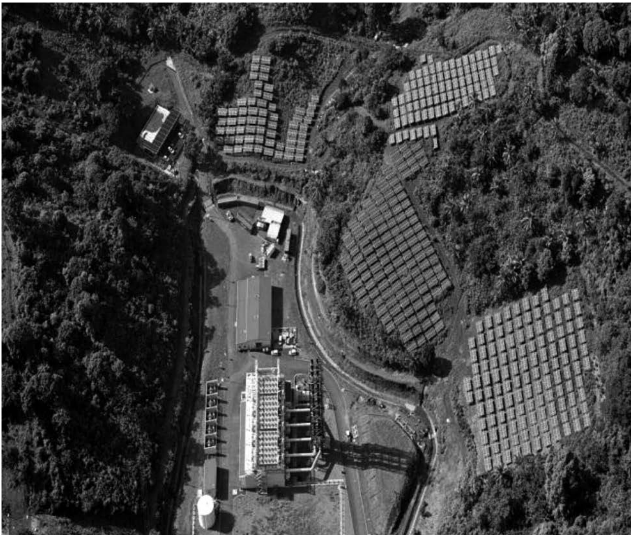
Photo 1 : Ferme solaire au sol de Longoni (1 MWc) sur le site de la centrale thermique du même nom.
