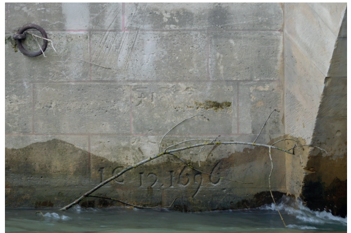
Figure 1 : Repère du niveau de la crue du 16 décembre 1696 sur un pilier d'un pont de Paris
