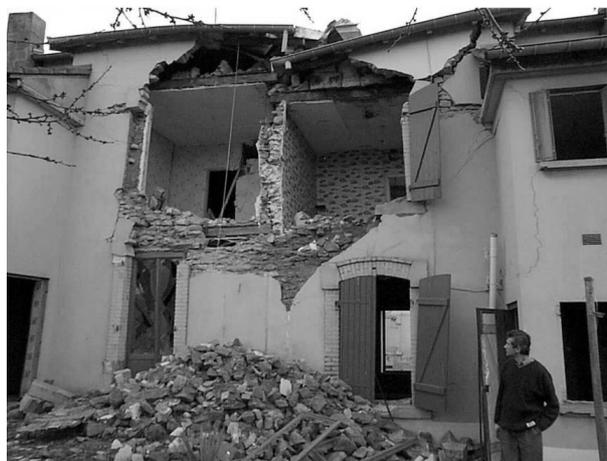
Figure 2 – Dommages causés au bâti par les désordres d'Auboué, en 1996.
