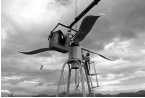
Figure 3 : Eolienne horizontale installée sur le toit d'Indesmedia EOL. ©Indesmedia EOL.
