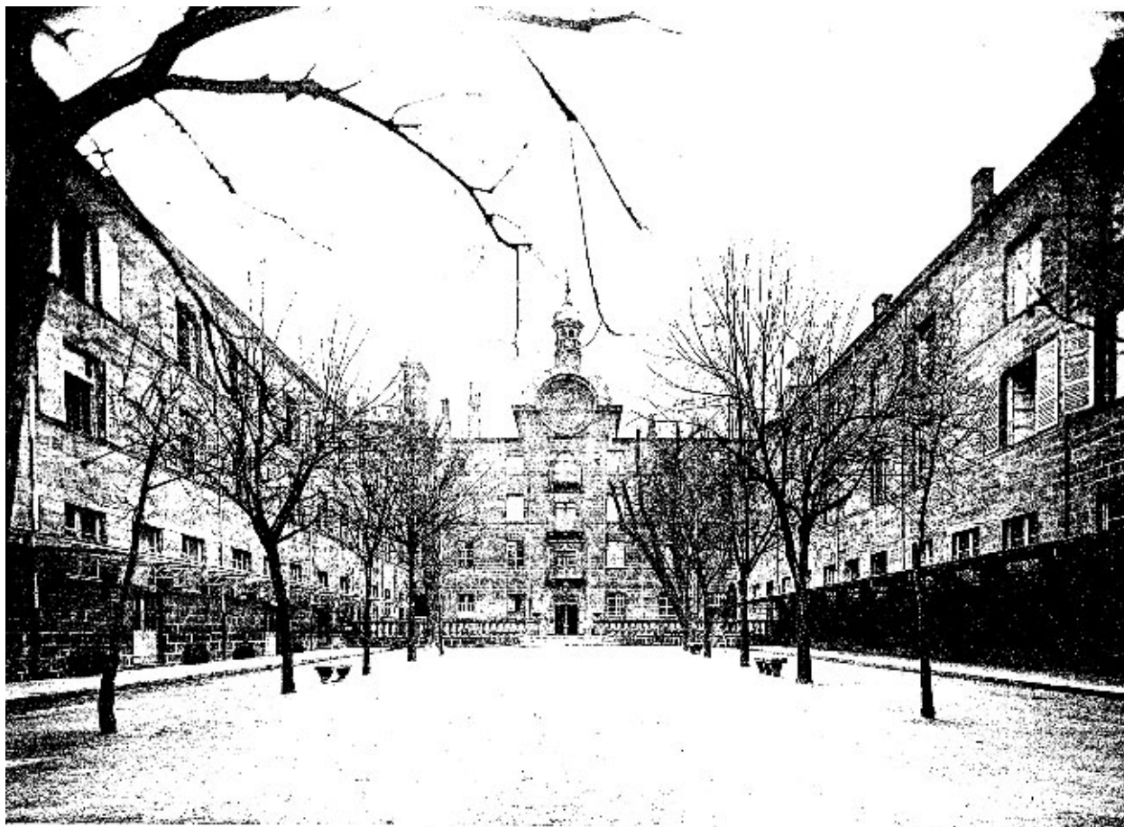
Cour d'Honneur &amp; façade intérieure
