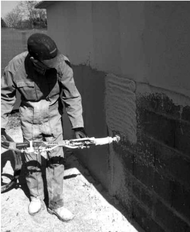
Application d'un mortier de façade réalisé à base d'aérogel de silice et de ciment. © Enersens
