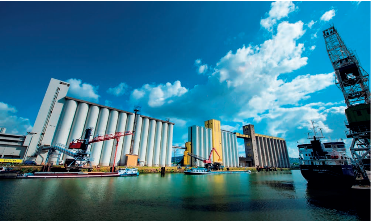
Poste de déchargement (par aspiration) des péniches à la Presqu'île d'Elie au cœur du port de Rouen.
