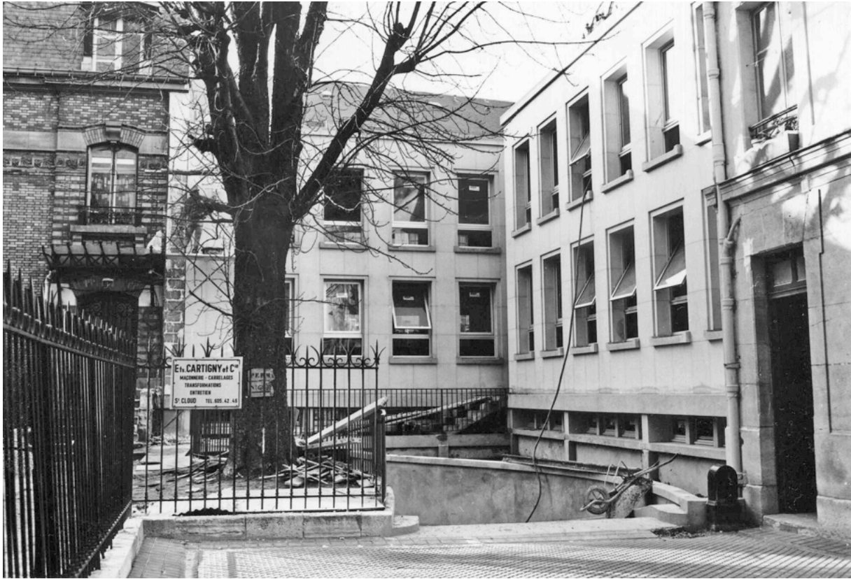
Fig. 1. La Maison de la géologie à la fin des travaux. La rampe courbe évite le marronnier qui mourut peu après et fut remplacé par celui que nous voyons aujourd'hui.
