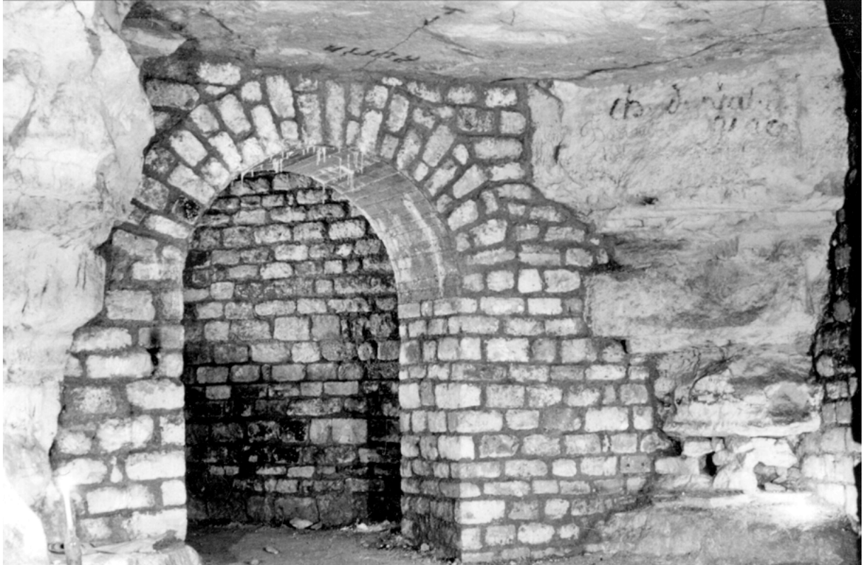
Fig. 3. La salle des carrières souterraines sous la Maison de la géologie en 1980. Confortations et coupe du Lutétien sur un pilier.
