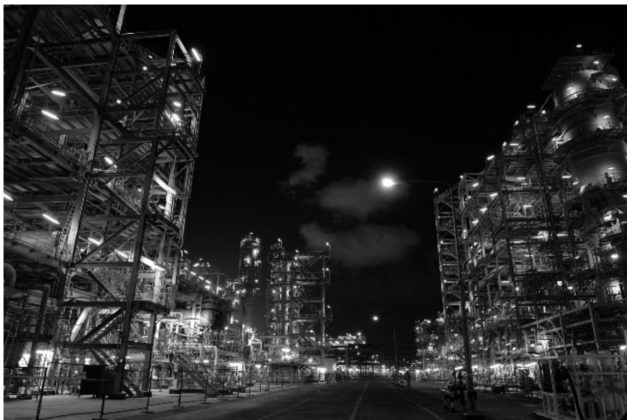
Vue de nuit d'installations de l'usine Pearl-GTL.
