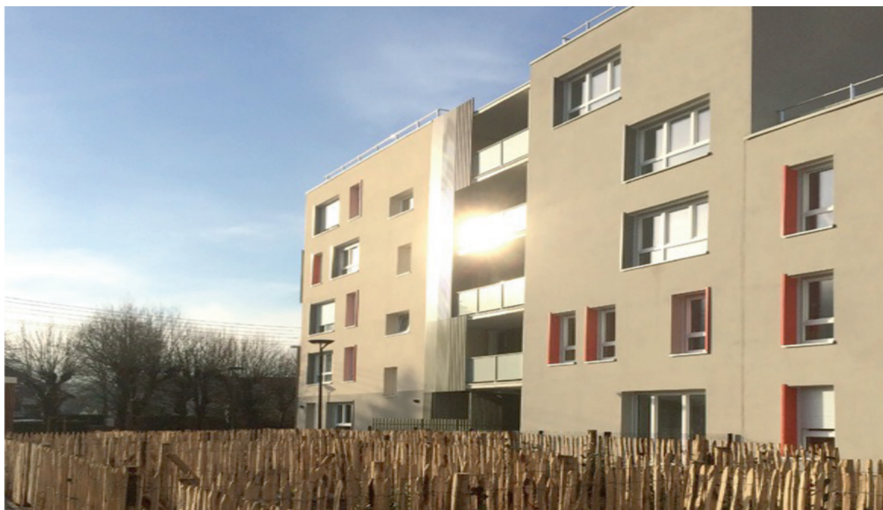
Figure 2 : La résidence Alizari du bailleur social Habitat 76 (MOA) à Malaunay (76), résidence labellisée E3C2.
