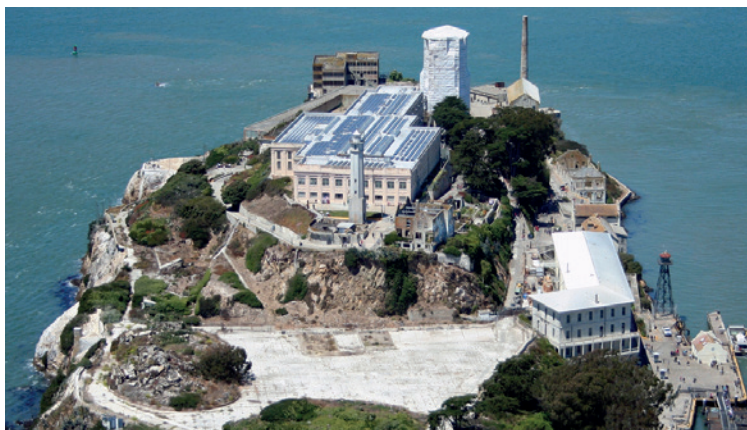
Photo 2 : Installation photovoltaïque de 305 kWc sur le site de l'ancienne prison d'Alcatraz.
