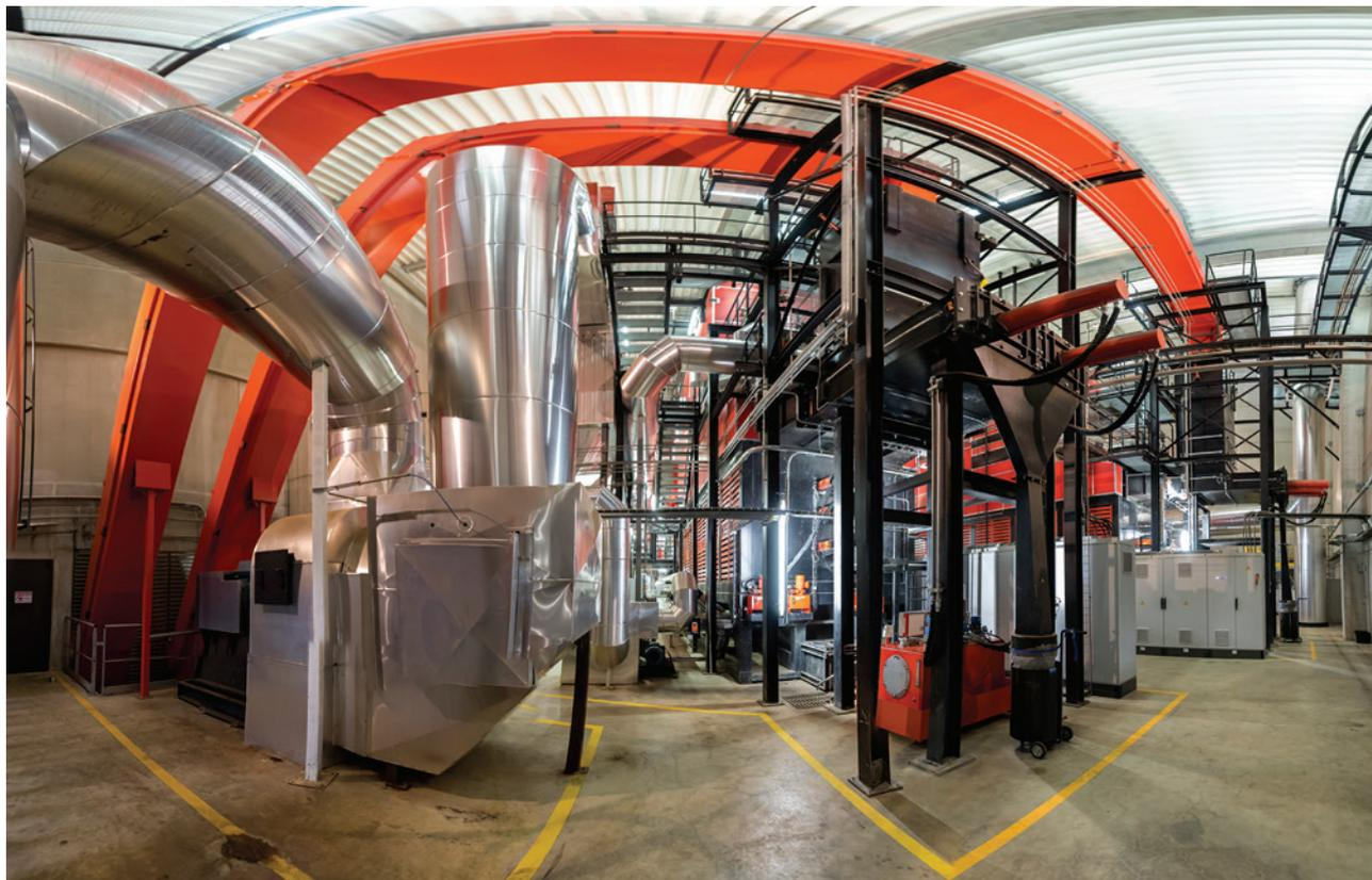
Réseau de chauffage urbain de la ville de Châlon-sur-Saône : chaufferie communale au bois de 130 mégawatts.
