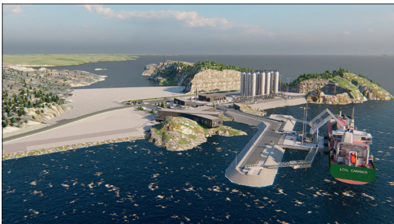
Figure 6 : Image de synthèse du site de stockage situé sur la côte de Naturgassparken (Norwegian Ministry of Petroleum and Energy, 2019-2020).
