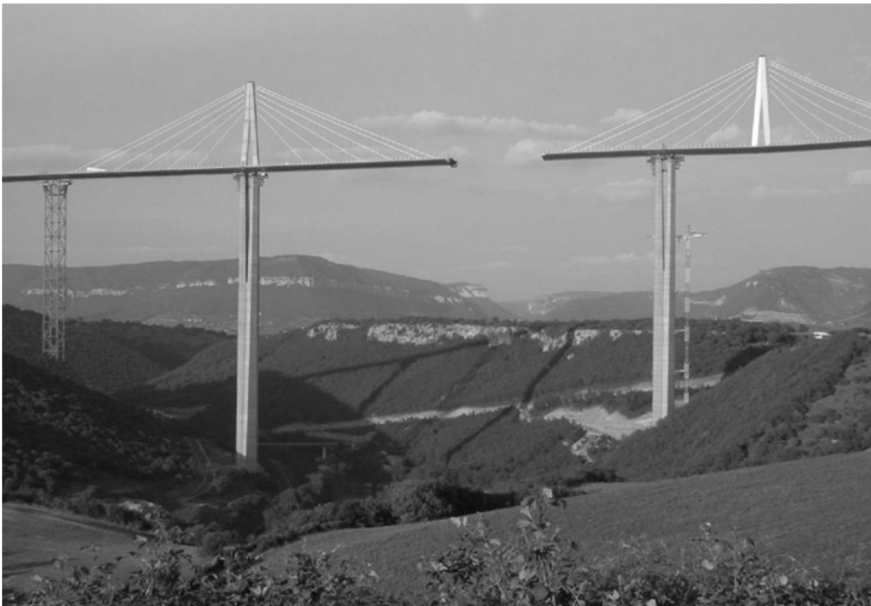
Figure 2 – Le tablier a commencé son dernier parcours de 171 m.
