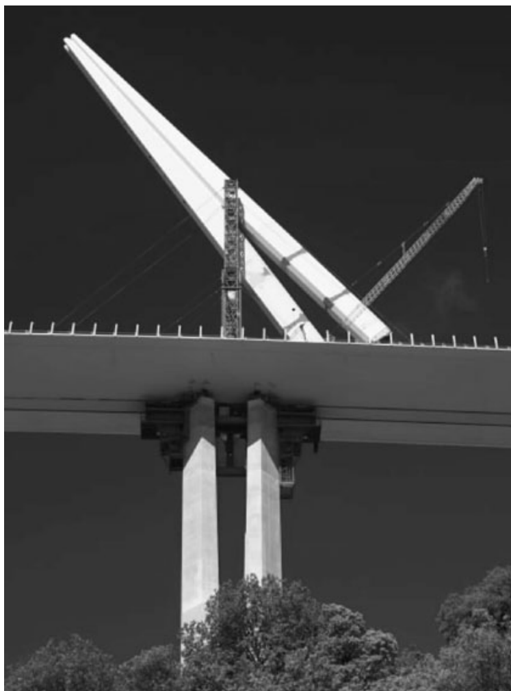
Figure 5 – Le pylône est mis debout.
