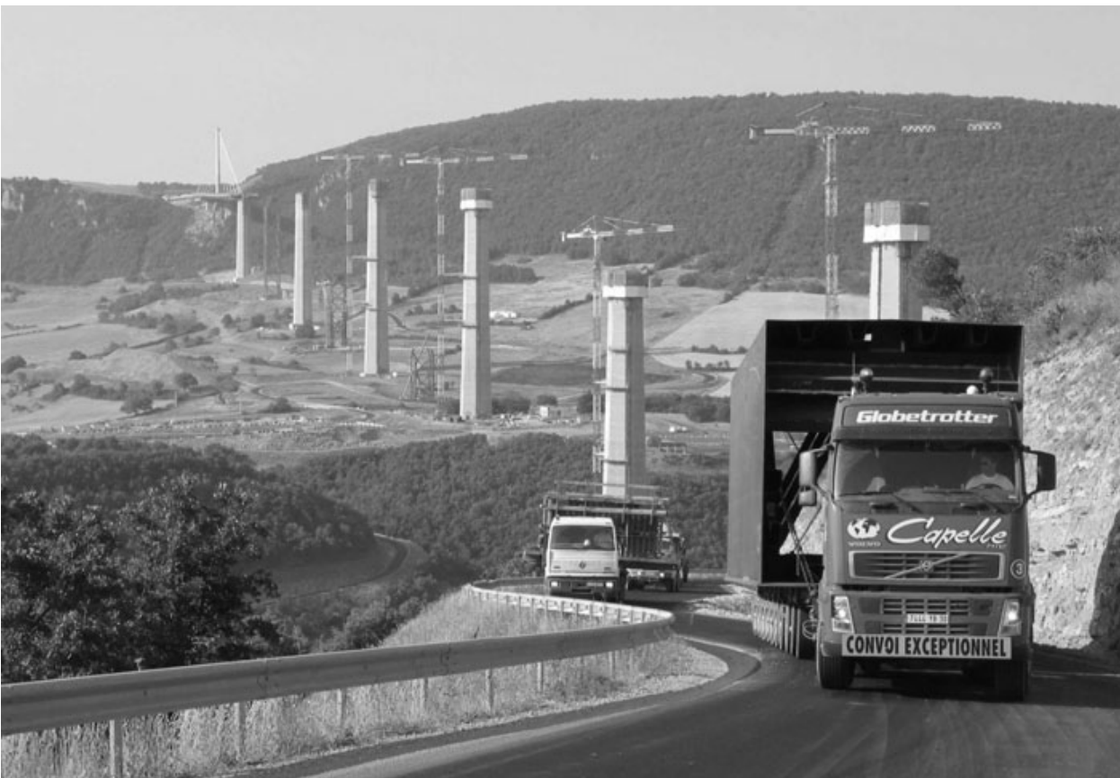
Figure 3 – Le chantier a été alimenté en flux tendu par une noria de camions. 2 000 transports ont été nécessaires pour amener à pied d'œuvre les 45 000 tonnes d'aciers pour la construction.
