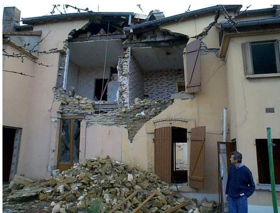
Figure 2 - Dommages causés au bâti par les désordres d'Auboué, en 1996.
