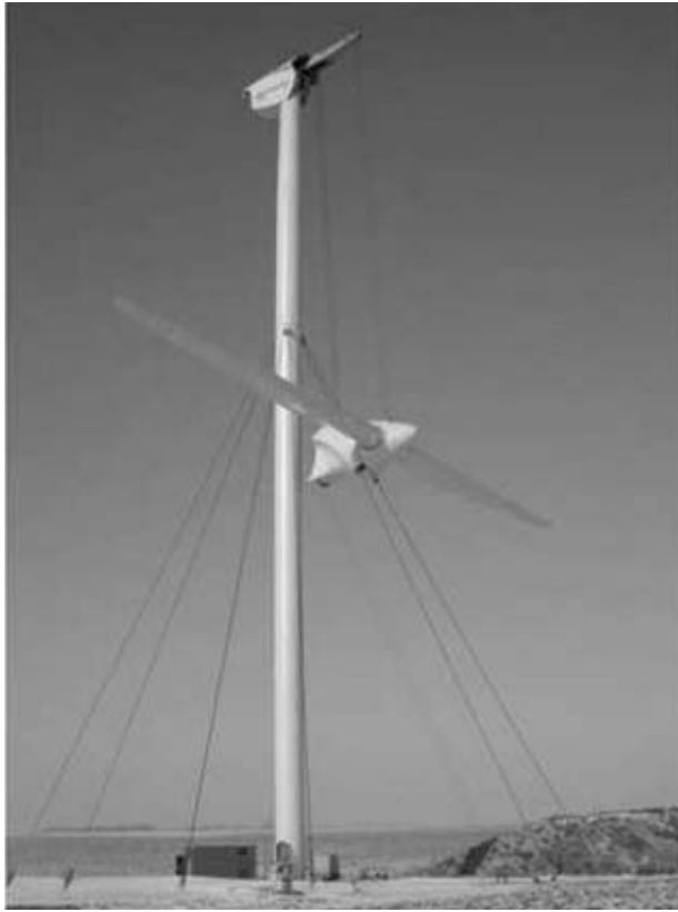
Photo 5 : Eolienne Vergnet GEV HP 1 MW (Source : Vergnet).
