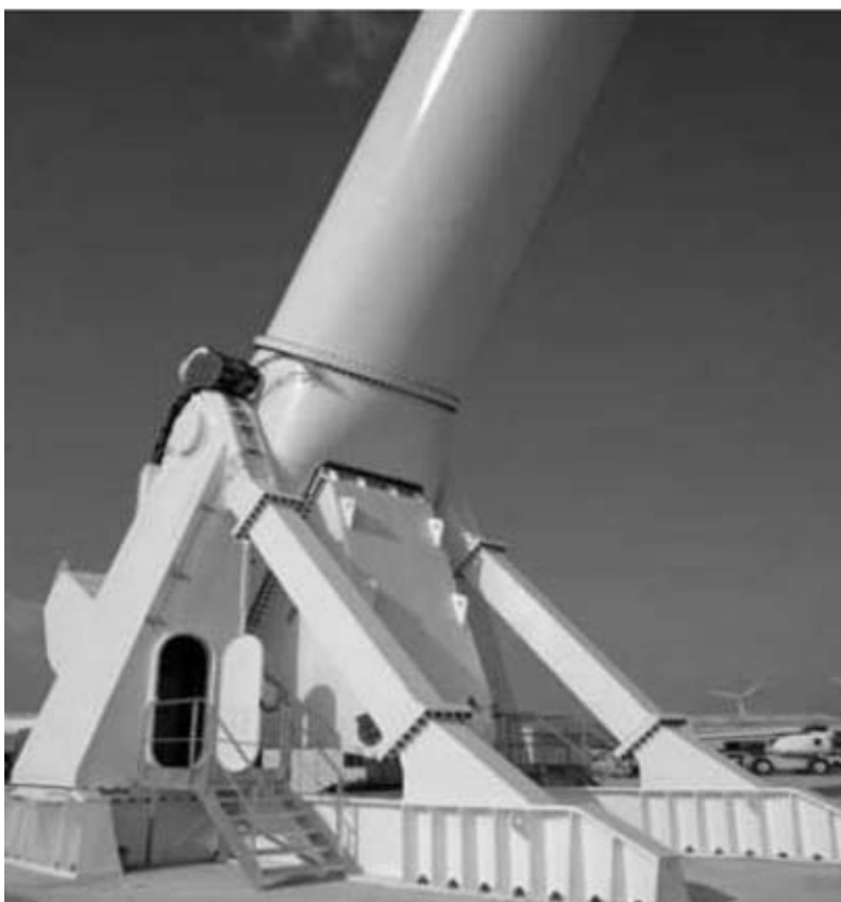
Photo 3 : Un soubassement d'éolienne dont la fabrication est prévue à Lons-le-Saunier ( photo ALIZEO ).
