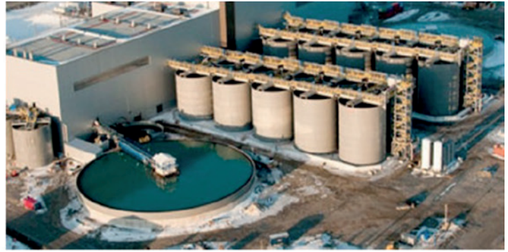
Figure 7 : À gauche : exemple de lixiviation en tas. À droite : des cuves de cyanuration et utilisation du procédé d'adsorption sur charbons actifs.
