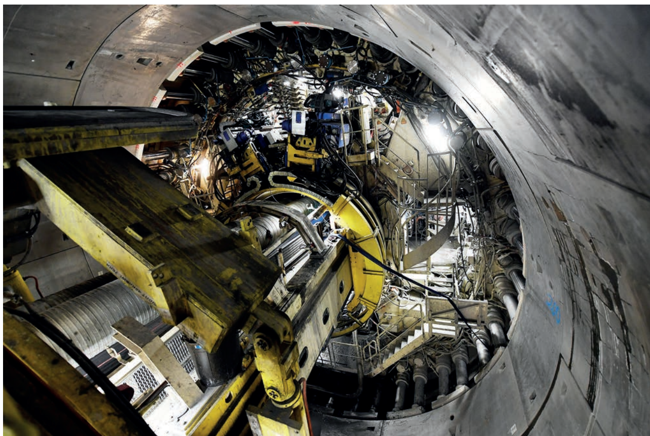
Creusement du tunnel de base de la liaison Lyon-Turin – Photo © TELT (Tunnel Euralpin Lyon Turin).
