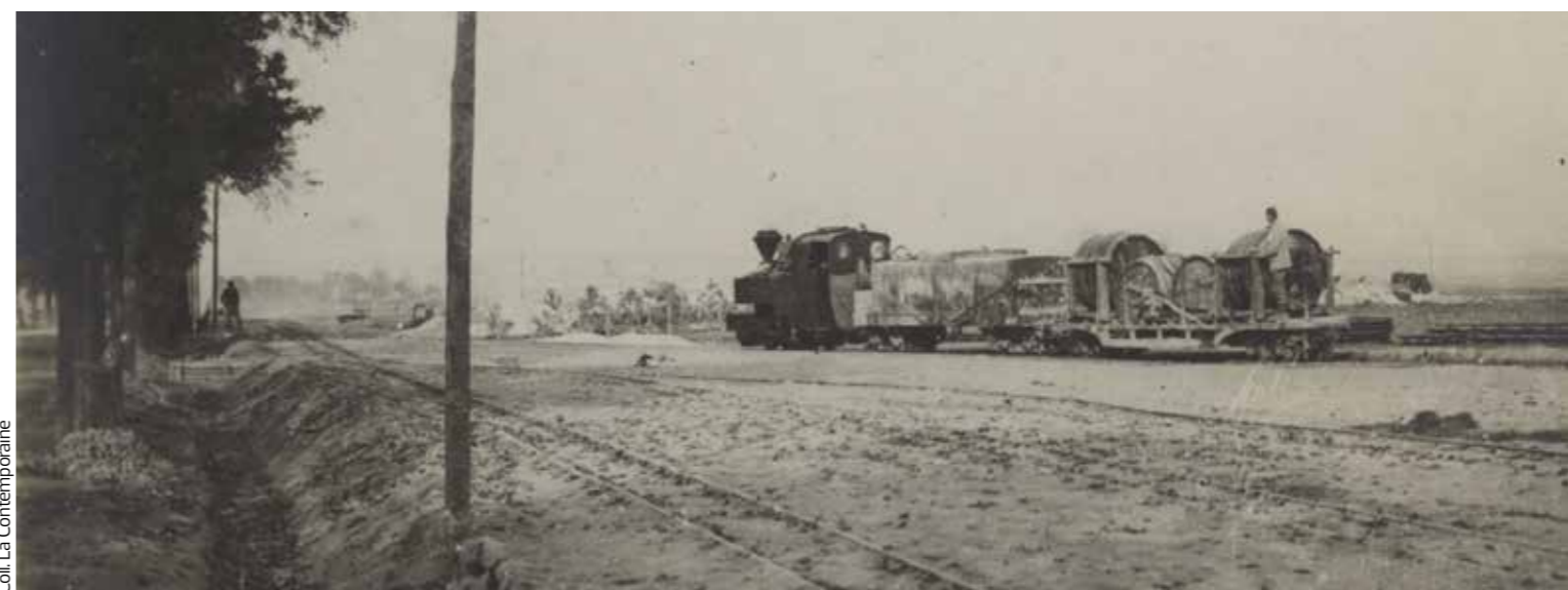
Une autre fonction critique la voie de 60 est le transport de l'eau potable. Cette 030 T Kerr-Stuart remorque un wagon-citerne Decauville 1915 et une plate-forme Péchot chargée de tonneaux.
