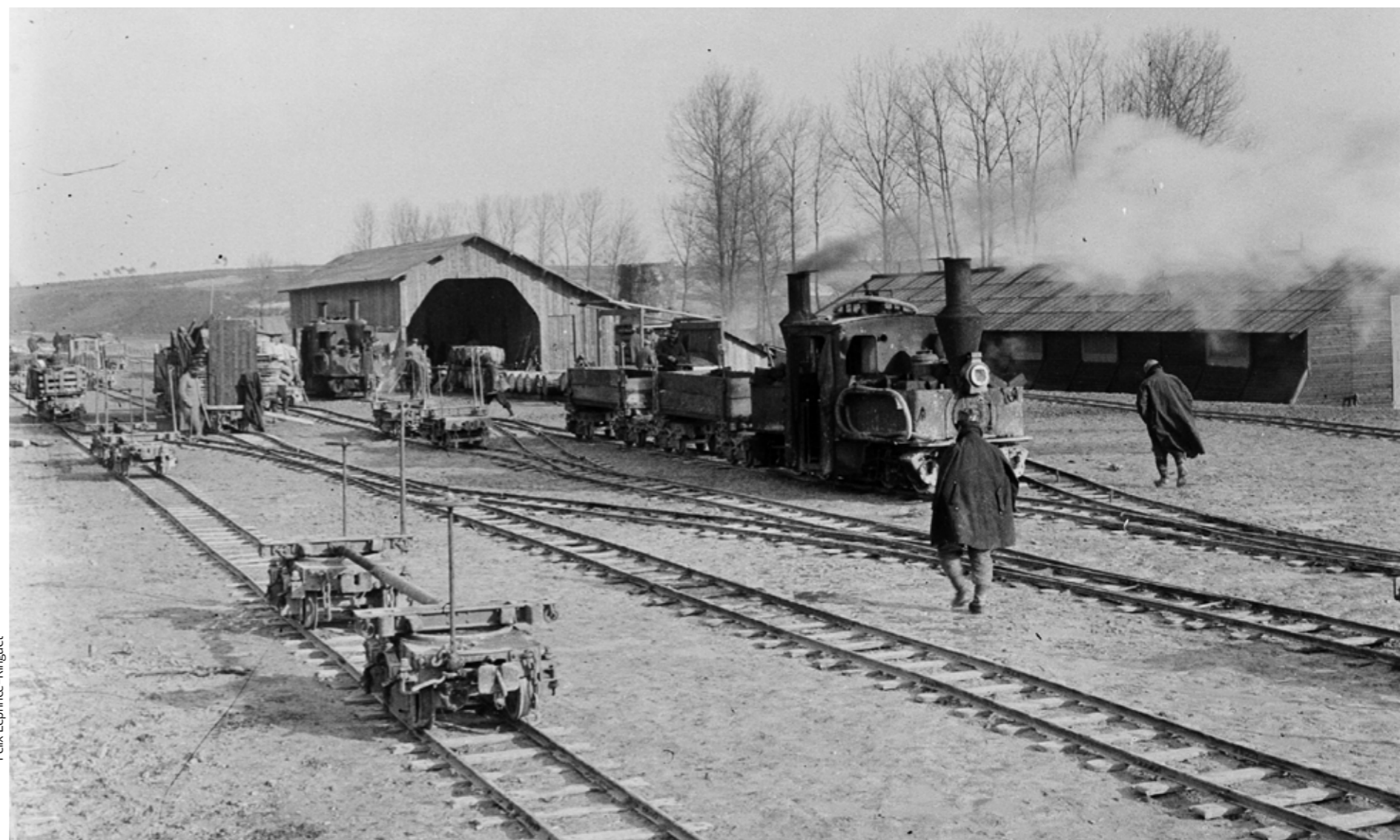
Un dépôt en cours d'installation.
