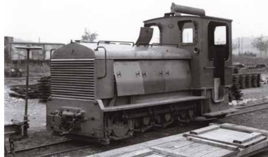
Le locotracteur LG n° 30 quelque part sur le front. Les inscriptions sur les capots sont là pour faciliter leur démontage et leur remontage lors des entretiens.
