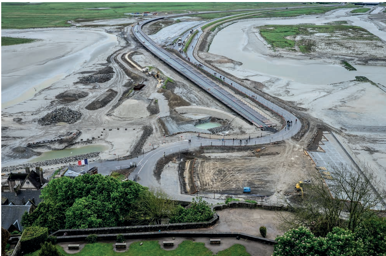
Chantier visant à rétablir le caractère maritime du Mont Saint-Michel.
