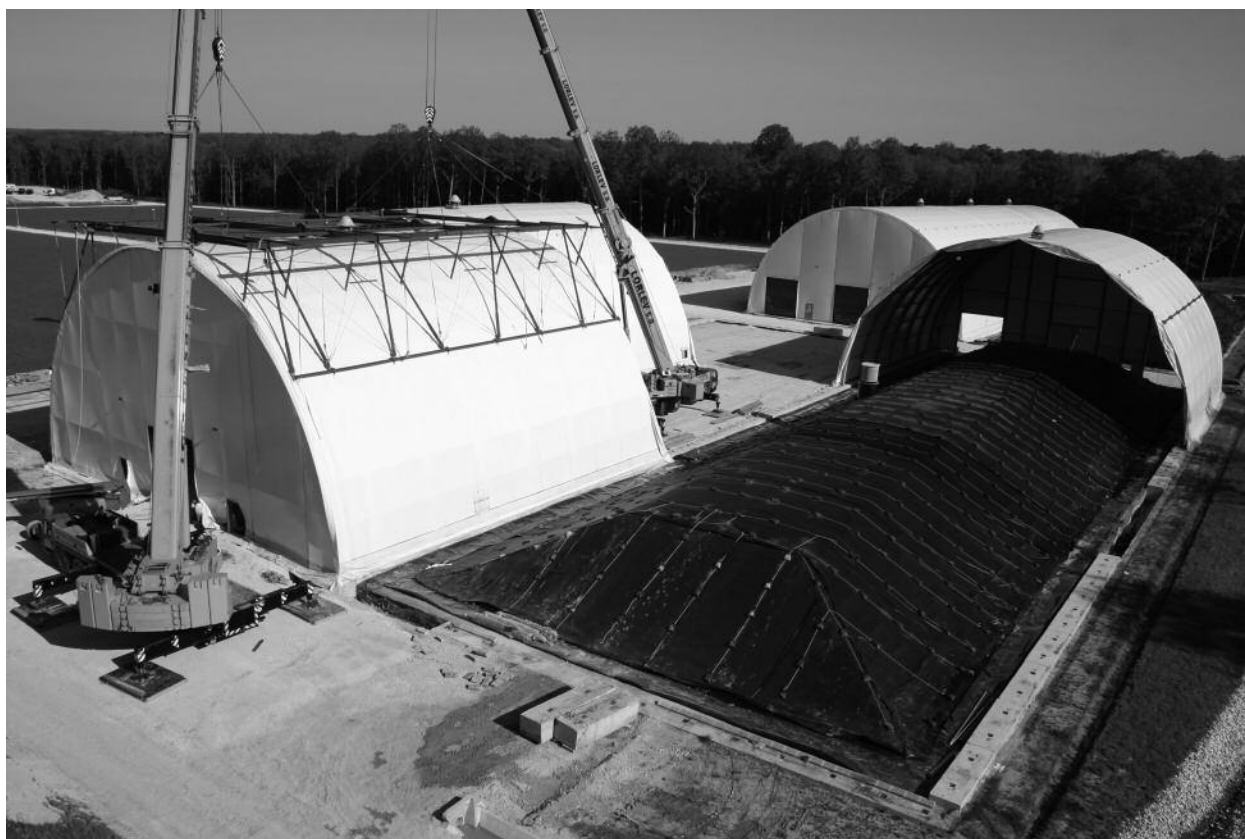
Photo 5 : Fermeture d'alvéole et déplacement de la toiture mobile.
