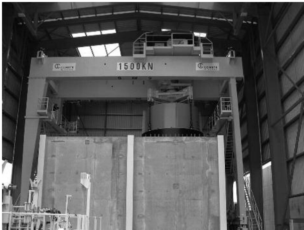
Photo 3 : Stockage en ouvrage dédié d'un couvercle de cuve de réacteur à eau sous pression (90 à 120 tonnes).
