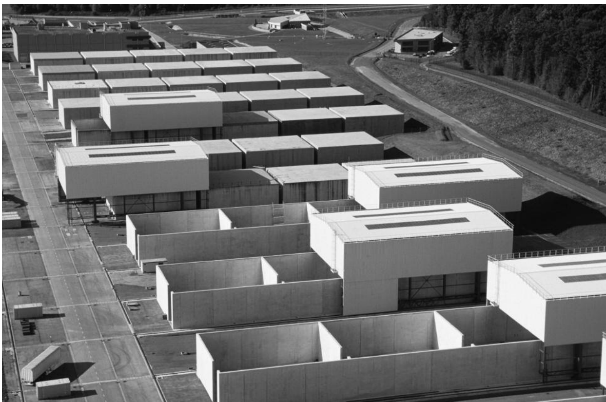
Photo 1 : Ouvrages de stockage du CSFMA.
