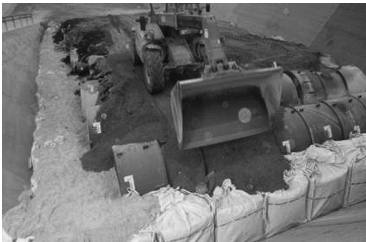
Photo 6 : Vides remplis de béton.
