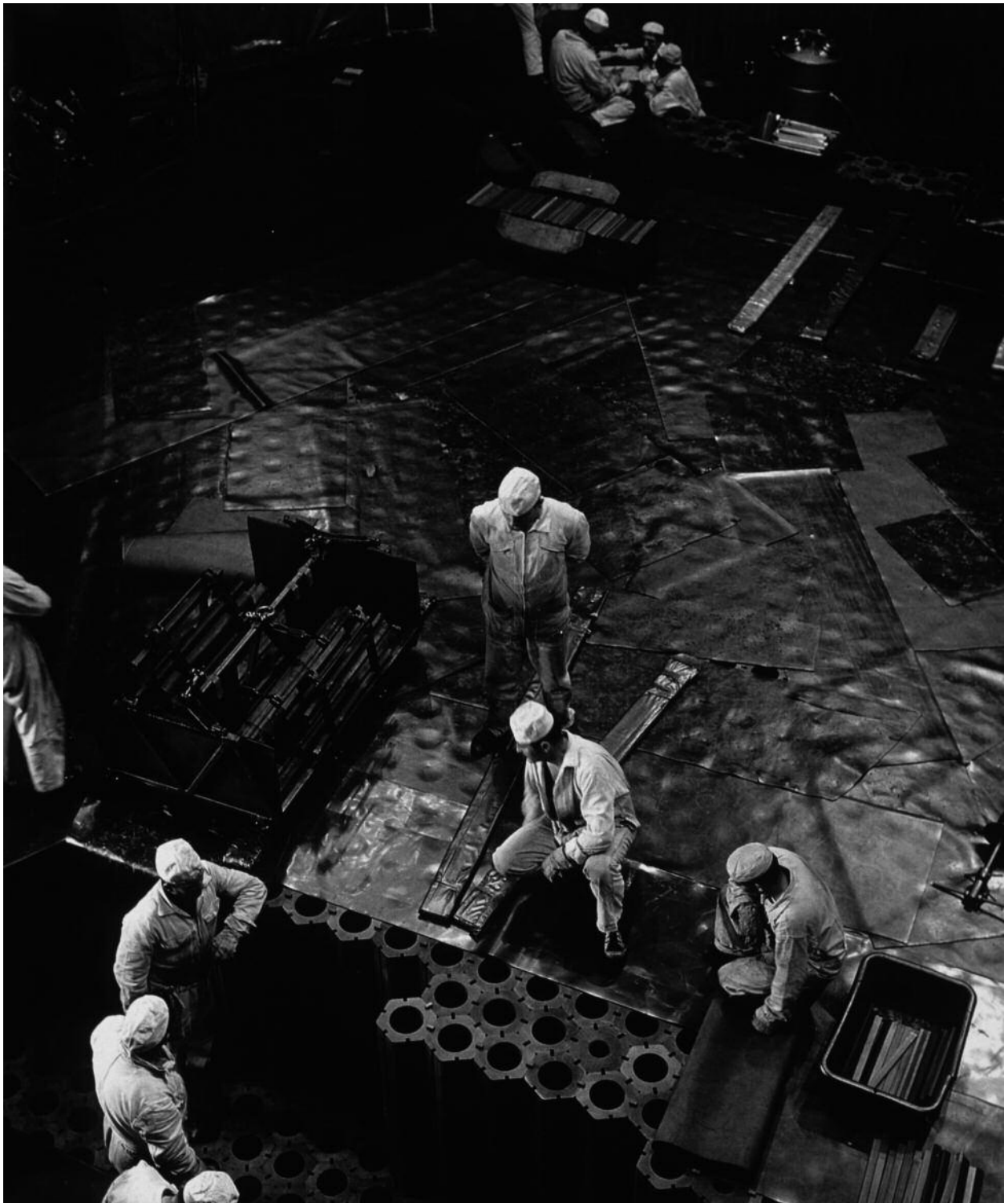
Figure 11 : Mise en place des empilements de graphite lors de la construction d'une centrale UNGG.
