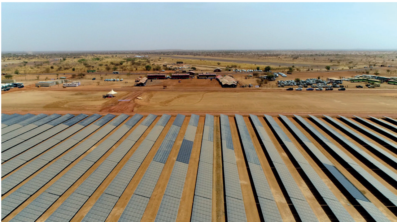
Figure 1 : La mine d'or d'Essakane du groupe IAMGOLD. Au premier plan, la centrale solaire d'une capacité de 15 MWc installée par Total Eren et AEMP en complément du système de générateurs diesel existant.
