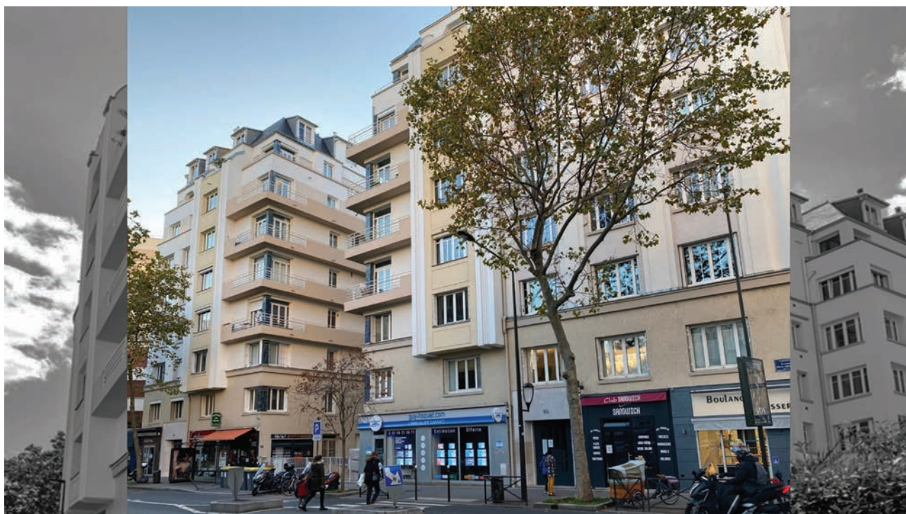
Rénovation énergétique (niveau BBC) et architecturale de l'immeuble Art Déco Pierre de Coubertin à Boulogne Billancourt. L'utilisation d'enduits à base d'aérogel a permis de conserver l'aspect original des reliefs de la façade. Architecte Group A&M- Reezome.
