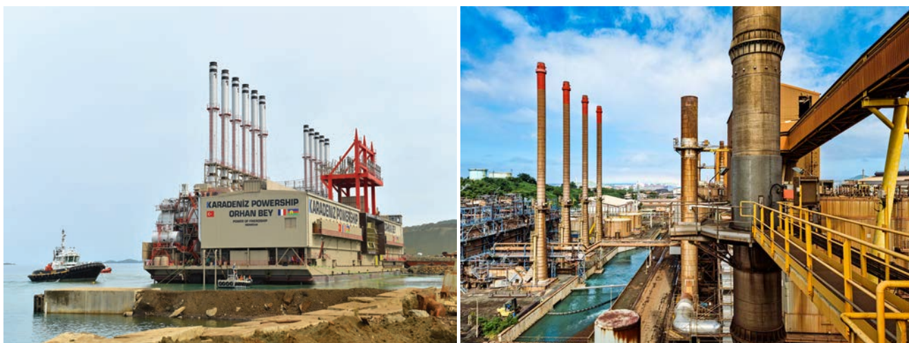
Photos de la centrale accostée temporaire dite CAT (© SLN).
