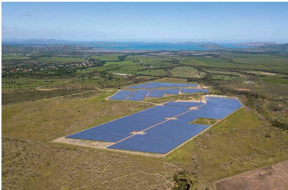
Figure 8 : Source : centrales solaires Hélio Boulouparis 1 & 2 (respectivement 12 MWc, 15,8 MWc + 9,5 MWh ESS). Crédit photo : TotalEnergies – Héos Marine Pacifique.
