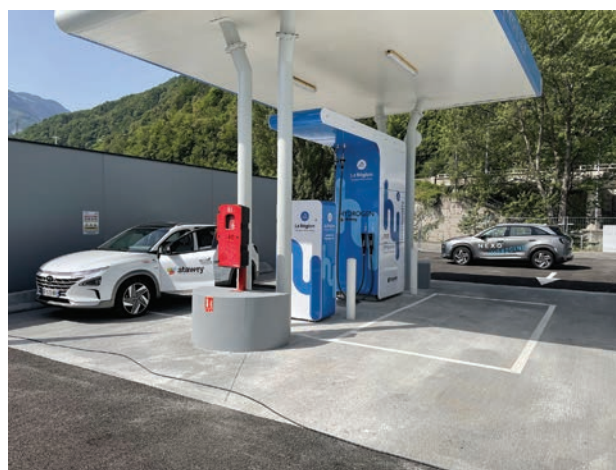
Figure 1 : Station de recharge hydrogène Ataway à Moûtiers, en région Auvergne-Rhône-Alpes – Photo©Ataway.
